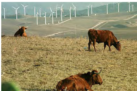
Figura 20. Aerogeneradores en Parque eólico de Casares. Imagen de Internet.
