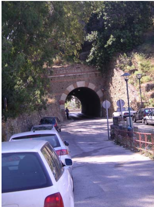
Aparcamiento de vehículos en túnel de Mundo Nuevo
